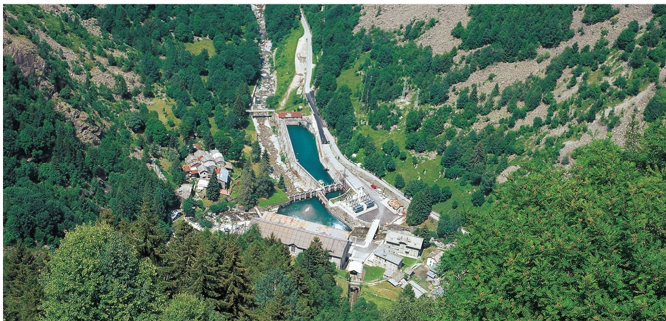
Panoramica dell'impianto di Vedello
